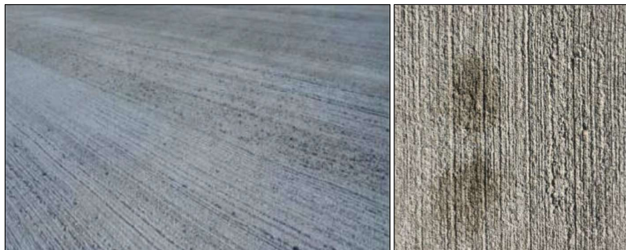
4 pav. Betono paviršius brauktas šepetėliu
